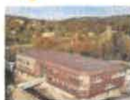
Bâtiment de la Communauté de communes Conques Montbazens Énergie : solaire, géothermique, PÉ, etc.
