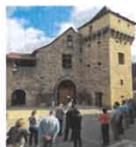
Chaufferie bois mairie, école, MAM, cantine, logement de Montels Ouest Aveyron Communauté
