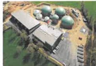
Méthanisation agricole collective Communauté de communes Montbazens
