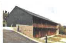
Maison de santé de la Postolle - Ouest Aveyron Communauté Médicaux associatifs et isolation verticale, ventilation double flux, pompe à chaleur géothermique
