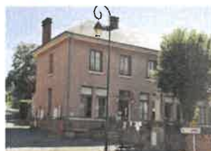
Réseau chaleur bois mairie, école, salle des fêtes de Pruines Communauté de communes Conques Marcillac
