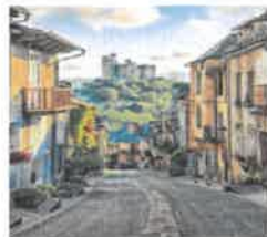
Réseau chaleur bois citoyen pour 10 bâtiments (6 publics + 4 privés) de Najac Ouest Aveyron Communauté
