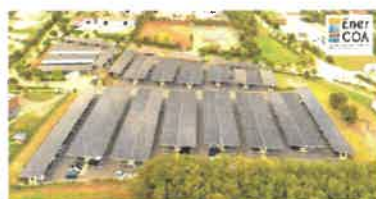
Ombrières photovoltaïques citoyennes 2,3 MW en autoconsommation collective ZA de la Glèbe à Laramière - Ouest Aveyron Communauté
