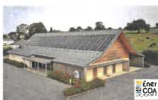
Toiture photovoltaïque citoyenne 36kW Salle d'animation de Gramond - Pays Ségali Communauté
