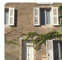
L'encadrement assure généralement la fonction d'appui de baie. Les appuis de baie, lorsqu'ils existent, sont réalisés en pierre et intégrés à l'ornementation de la façade. Ces appuis sont à conserver et restaurer.
