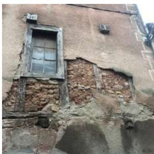
Lors de la restauration d'une façade, un diagnostic simple de la façade est à faire. La façade possède une certaine composition, des matériaux homogènes, des règles de construction. Ces éléments doivent être pris en compte. L'âge et les évolutions subies ont parfois fragilisé les constructions et la structure bois a pu souffrir de travaux inadaptés : sciage d'éléments porteurs pour des créations d'ouverture, travaux intérieurs provoquant l'enfermement et l'humidification des bois, etc...
