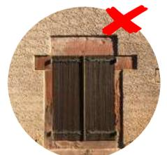
**LA TENDANCE OBSERVÉE AUJOURD'HUI EST DE METTRE À VUE LES MAÇONNERIES. OR, A L'ORIGINE, LA PLUPART DE CES MURS ÉTAIENT ENDUITS. MALHEUREUSEMENT, SANS PROTECTION (CONTRE L'HUMIDITÉ, LES VARIATIONS THERMIQUES) CES MURS SONT VULNÉRABLES ET FRAGILISÉS, LEUR DURABILITÉ EST RÉDUITE.**
