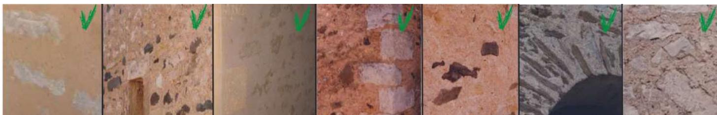
UN BON REJOINTOIEMENT SE SITUE AU NU DES PIERRES. LE MORTIER EST TOUJOURS PLUTÔT EN EXCÈS, JAMAIS EN RETRAIT. LES PIERRES AFFLEURENT À LA SURFACE DU MORTIER AVEC UNE TEINTE TERRE EN ACCORD AVEC L'ENVIRONNEMENT IMMÉDIAT. LES PETITES PIERRES NOYÉES RESTENT INVISIBLES. LES JOINTS SONT BROSSÉS OU RACLÉS À LA TRUELLE, JAMAIS LISSÉS.
