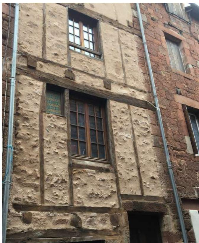
Ce sont des bâtiments construits essentiellement entre le XVe et le XVIIIe siècle. Leur structure porteuse est composée d'un assemblage de pièces de bois formant la façade de la maison et appuyée contre des murs de pierre. Elle supporte les charges et n'est pas décorative. Les vides entre poutres et poteaux sont comblés par un remplissage de type torchis, briquette, protégés par un enduit recouvert d'un badigeon à la chaux.
