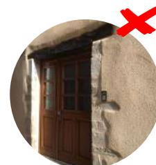
**LA TENDANCE OBSERVÉE AUJOURD'HUI EST DE METTRE À VUE LES MAÇONNERIES. OR, A L'ORIGINE, LA PLUPART DE CES MURS ÉTAIENT ENDUITS. MALHEUREUSEMENT, SANS PROTECTION (CONTRE L'HUMIDITÉ, LES VARIATIONS THERMIQUES) CES MURS SONT VULNÉRABLES ET FRAGILISÉS, LEUR DURABILITÉ EST RÉDUITE.**
