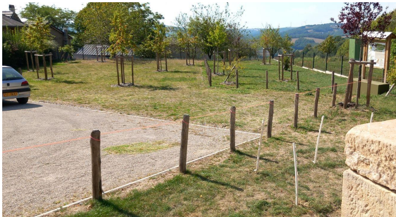
Parking désimperméabilisé (commune de Labastide Solages)
