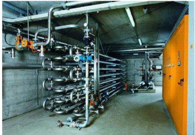
Figure 41: Echangeur tubulaire en sortie de STEP (Lyonnaise des Eaux, ISTINOX, ANTEA)
