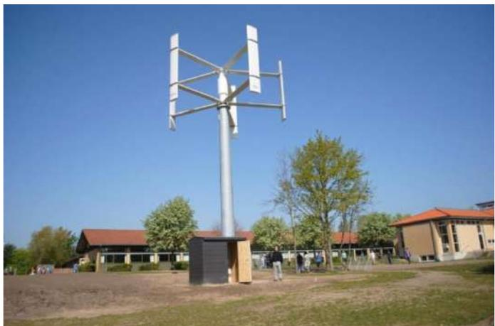
Figure 48 : éolienne Darrieus H de 6 kW
