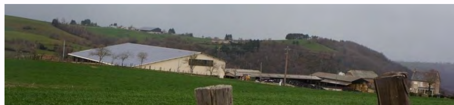
Bâtiment d'élevage plateau du Ségala – Source : E2D, 2016
